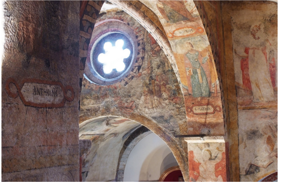
Interior de l'església de Sant Andreu de Salardú
